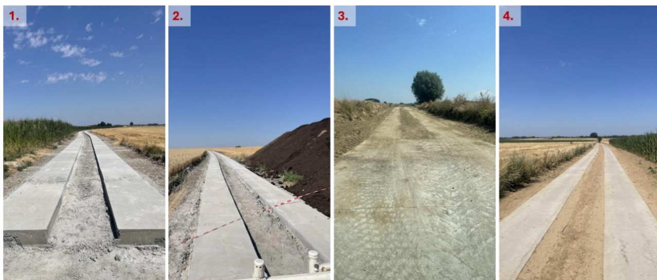
Figure 30 Illustration de ces aménagements de voiries agricoles et de mobilité douce réalisés dans le cadre de l'aménagement foncier (source : CSD, juil. 2026)
